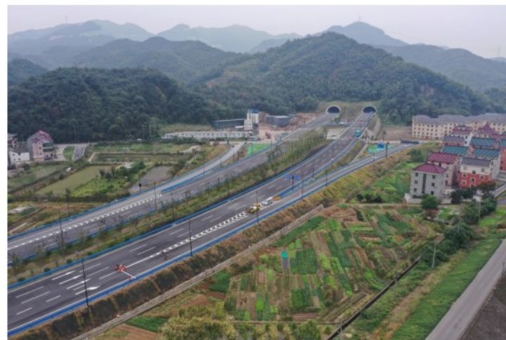
▲ 03省道萧山义桥至楼塔段改建工程
