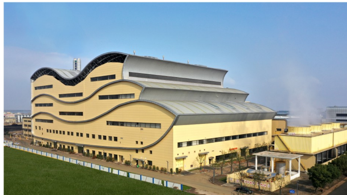
▲ 4000吨日污泥处理项目实景图
