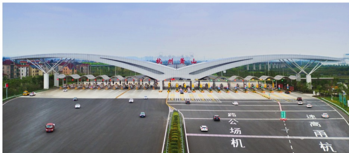
▲ 机场公路主线收费站
